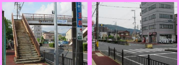
【御木本道路】 明倫小横歩道橋・ピザラ前交差点
