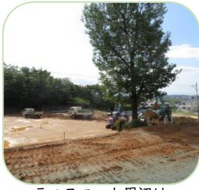
テニスコート周辺は 雨水対策の工事中です
