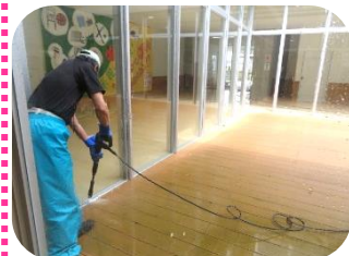
吹き抜きの洗浄
